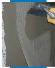
Rasatura dei pannelli termoisolanti arrmata con Rete in Fibra di Vetro annegata nello strato di Mapetherm AR1
