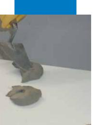
Applicazione di Mapetherm AR1 sul rovescio del pannello a punti con cazzuola
